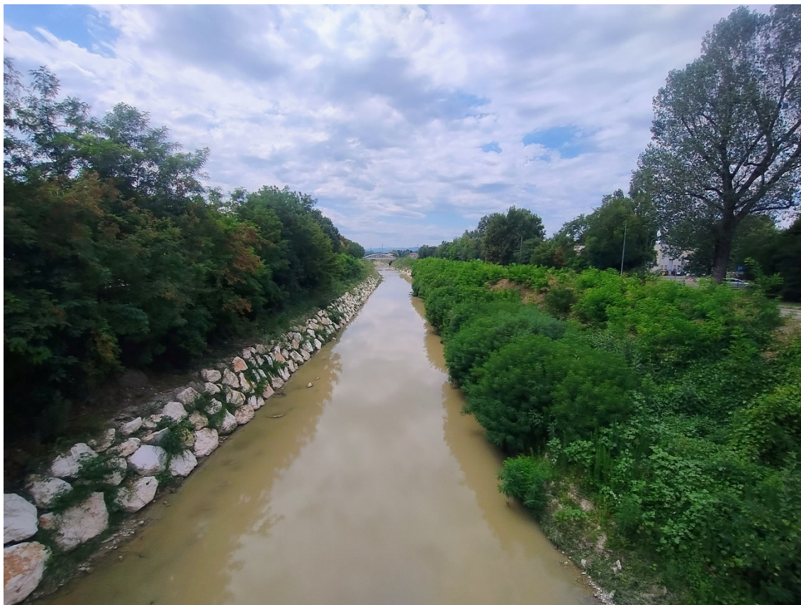
Vista verso sud del Torrente Tresinaro – Sulla destra l'area oggetto di intervento
