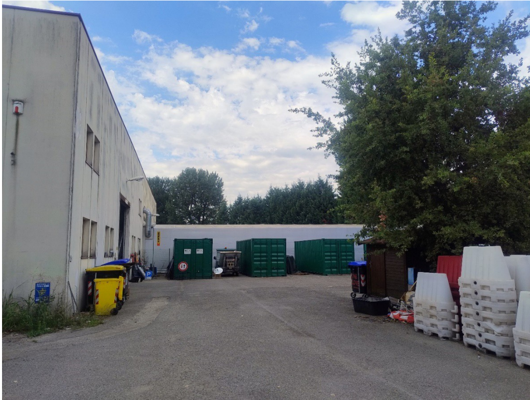
Prospetto nord magazzino comunale – Frontalmente area cortiliva su cui è previsto l’ampliamento.
