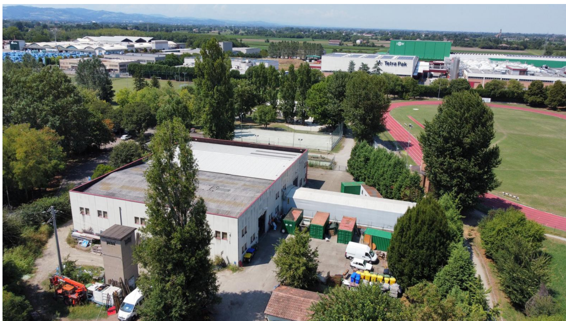
Vista con drone da punto zenitale su incrocio fra viale di accesso e via della Chiesa, prospetti est.
