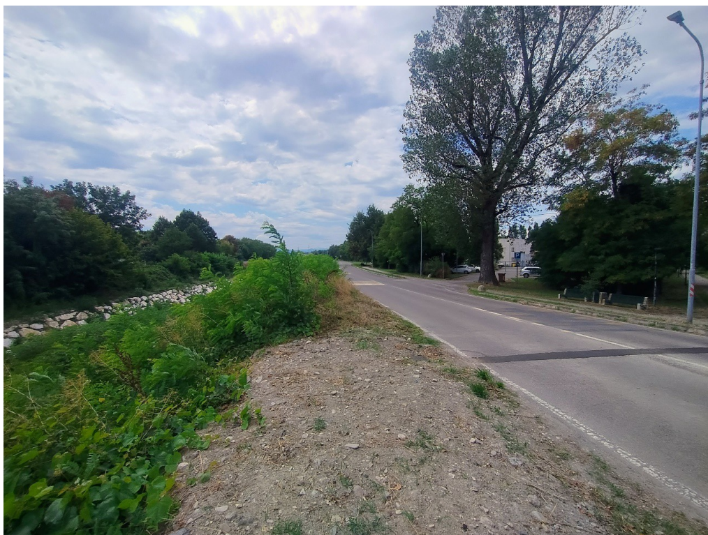
Vista verso sud – Argine del torrente Tresinaro, sulla destra si scorge l'ingresso esistente al magazzino comunale che si intravede sullo sfondo
