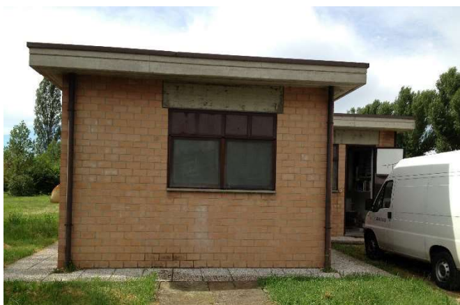
Figura 2. Locale quadri elettrici ed automazione. Struttura in muratura portante, solaio di copertura in laterocemento e cornici in c.
