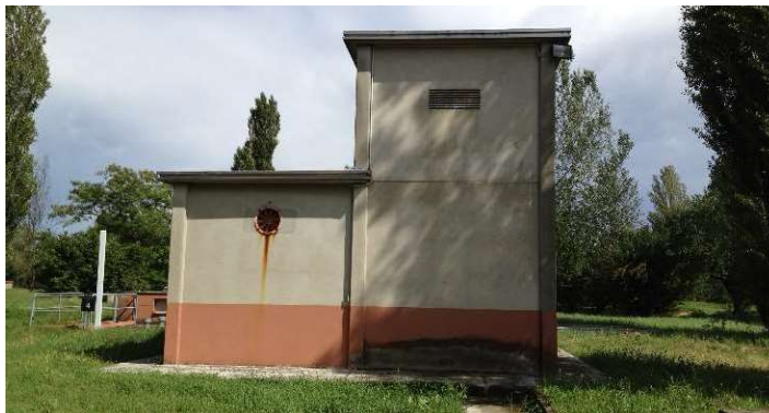
Figura 4. Locale Biossido. Struttura di tipo prefabbricato composta di pilastri e pannelli in c.a.
