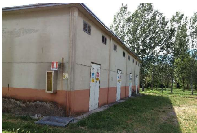
Figura 3. Cabina trasformatori elettrici. Struttura prefabbricata costituita da pilastri e pannelli in c.a
