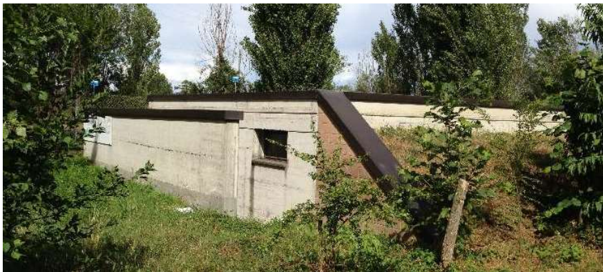
Figura 5. Tre camere di manovra parzialmente interrate, costituite da struttura interamente in c.a.
